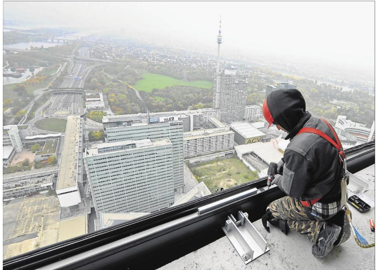
Zugangskontrolle: Beim Bau des DC Towers 1 wurden die Arbeiter mit elektronischen Ausweisen ausgestattet.
