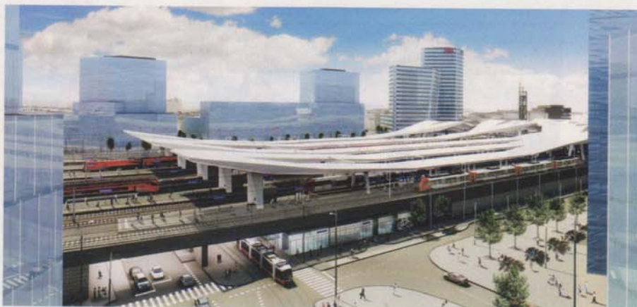
HAUPTBAHNHOF WIEN. Rund 55 Prozent der Flächen wurden bereits vermietet oder verkauft.
