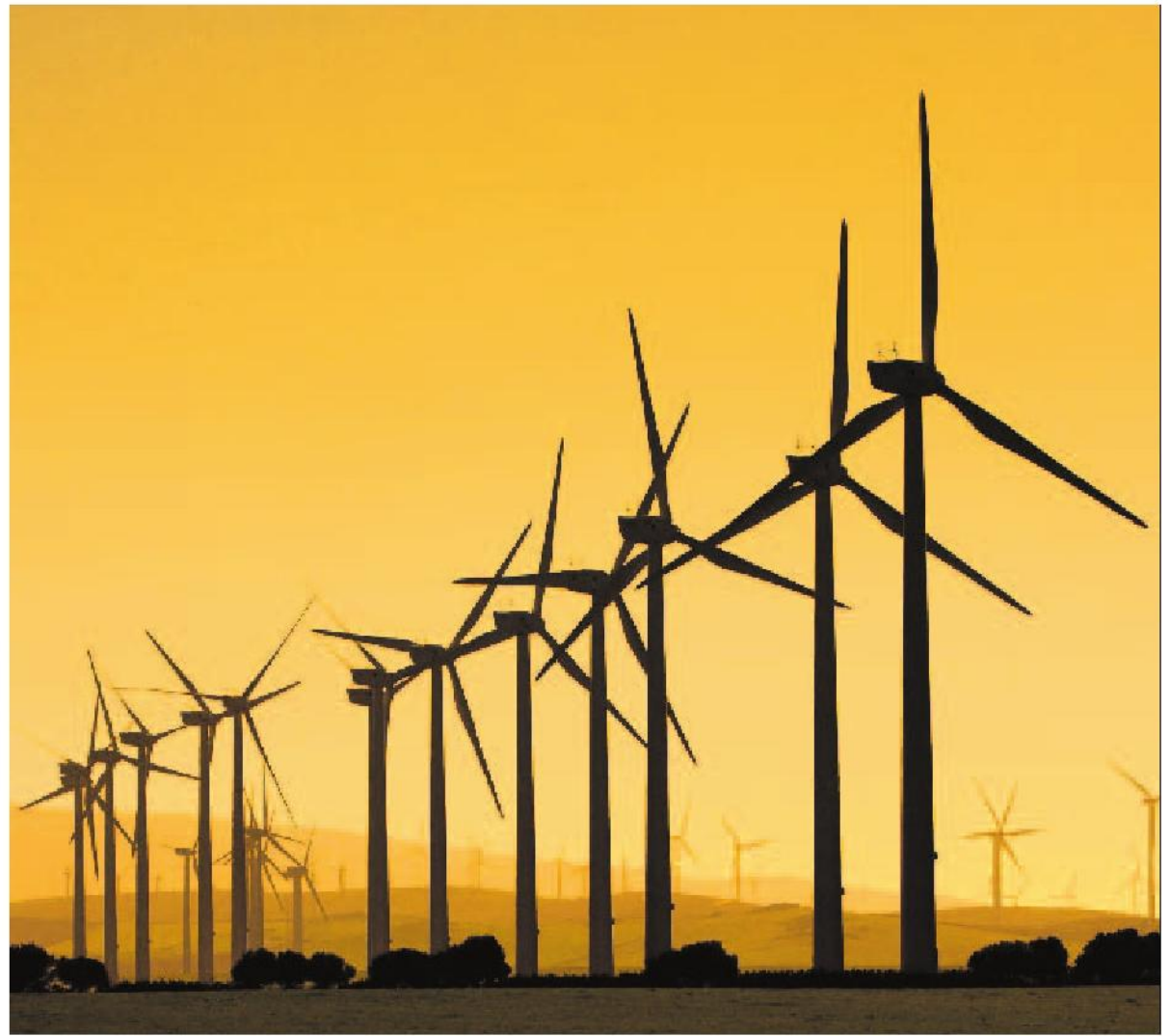
Windkraft- und Fotovoltaikanlagen sind gefragte Investitionsobjekte in Osteuropa. Doch neue Steuergesetze zur Regulierung des Marktes verunsichern Investoren. Fotos: Philipp Horak, Sandor Jackal-Fotolia.com
